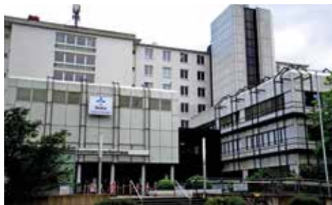
Blick auf das Diakonissen-Krankenhaus.
