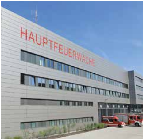
Blick auf die Hauptfeuerwache in Neckarau in der neben der Berufsfeuerwehr auch die Freiwillige Feuerwehr beheimatet ist. Bild: Gross
