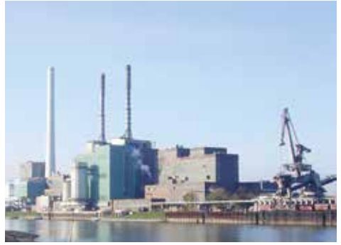
Blick auf das Großkraftwerk von der Rheinseite aus.
